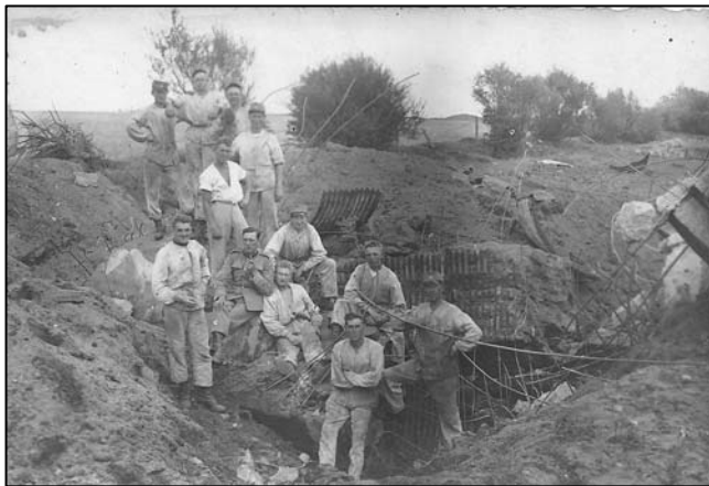
Sprængning af Sikringsstilling Nord.
